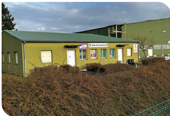
Toiture maison des associations & écoles - 149 019€
