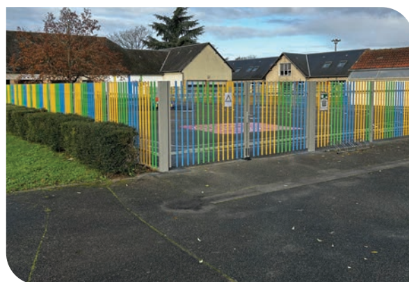
Clôture groupe scolaire, marquage au sol, volets et portes 63 536€
